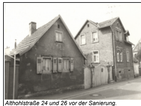
Althohlstraße 24 und 26 vor der Sanierung.
