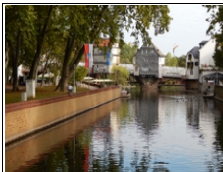
Blick von der Nahebrücke auf das Mühlentor, das leider teilweise verdeckt war, wegen Renovierungsarbeiten.
