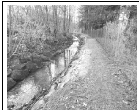
Das Bachbett ist abgemauert und der Weg geschottert.
