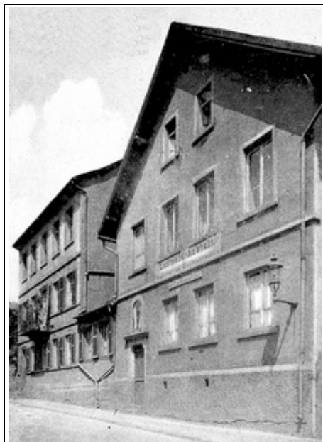
Luitpold-Anstalt in der Schweinheimer Straße. (Mittlerweile abgerissen)
